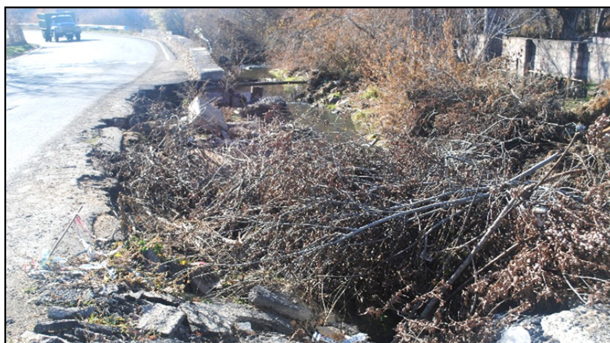
Рис. 4. Валежник, вынесенный селом и скопившийся перед мостовым проходом (фото автора).
